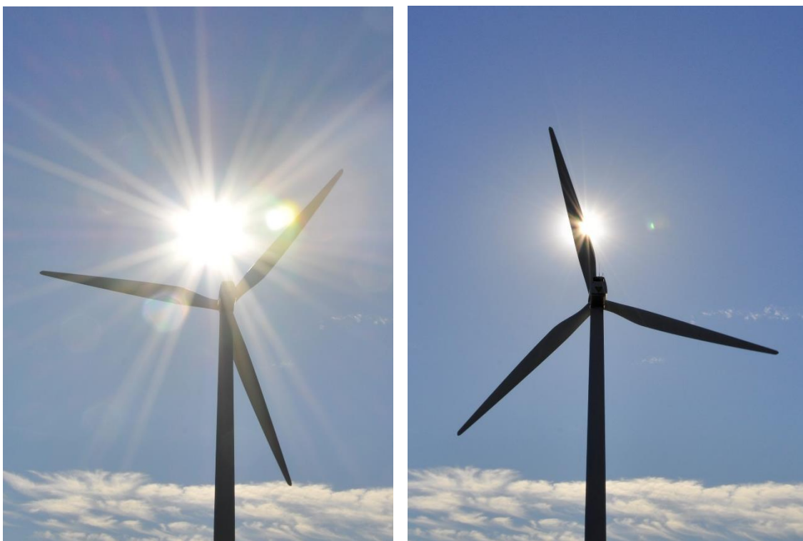
Kuva 9.88. Tuulivoimaloiden lavat aiheuttavat pyöriessään vilkkumista ja varjon välkkymistä aurinkoisella säällä.
