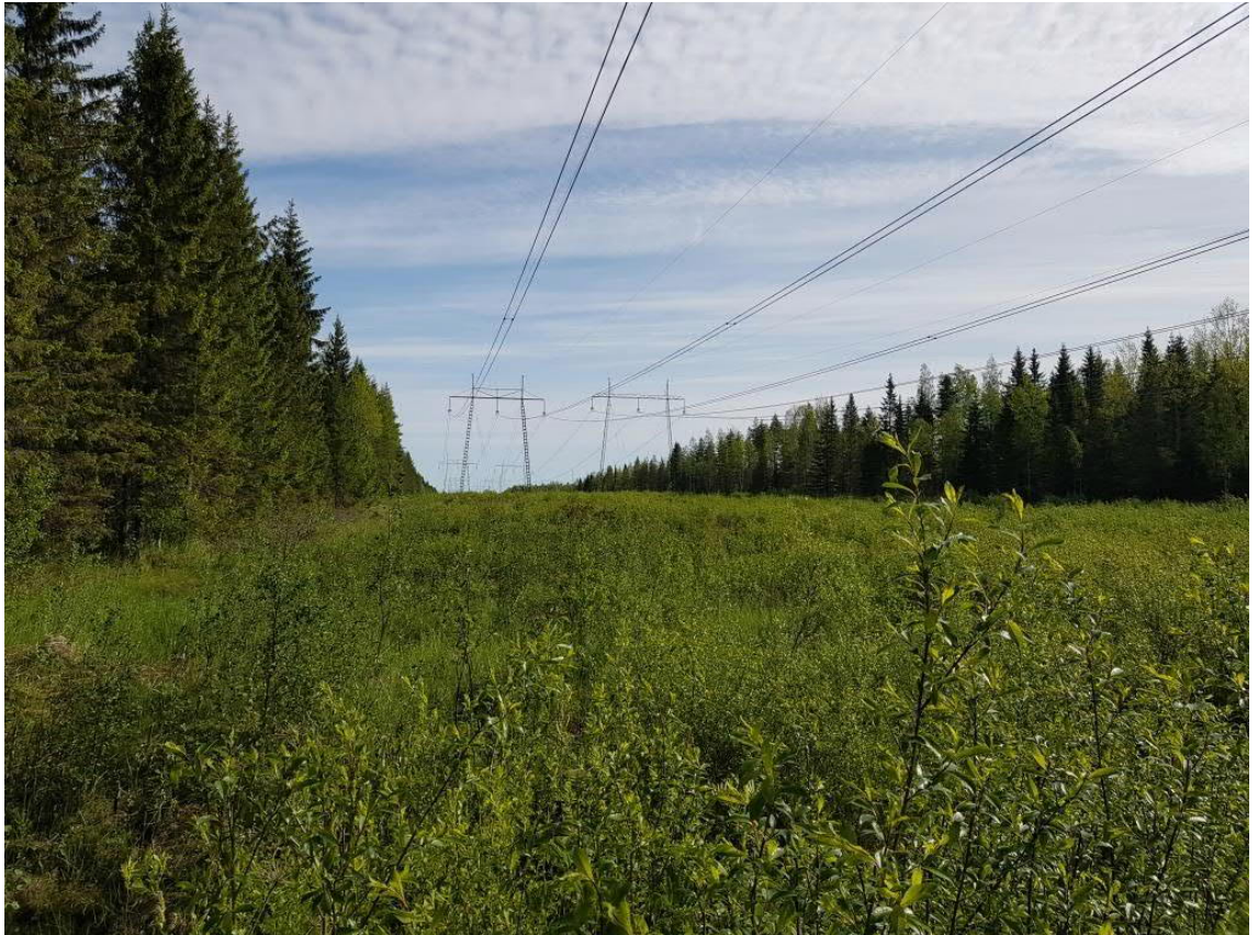
Kuva 5-2 Voimajohtokäytävät sijoittuvat pääasiassa metsäalueelle.
