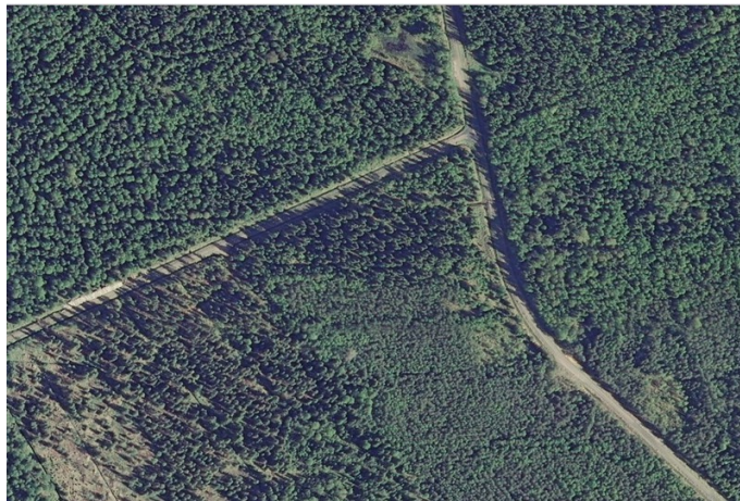
Kuva 11 a. Ortokuva, voimalapaikka kuvan keskellä.
