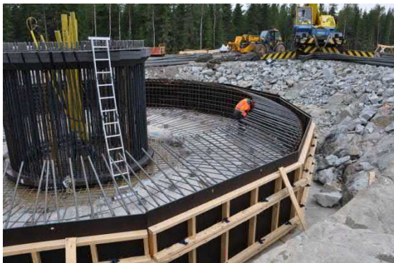
Kuvapari 4.14. Tuulivoimalan perustusten rakentamista. (Kuvat: Leila Väyrynen, FCG)
