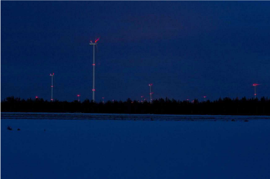
Kuva 4.4. Kiinteät punaiset lentoestevalot. (Kuva: Ville Suorsa, FCG)
