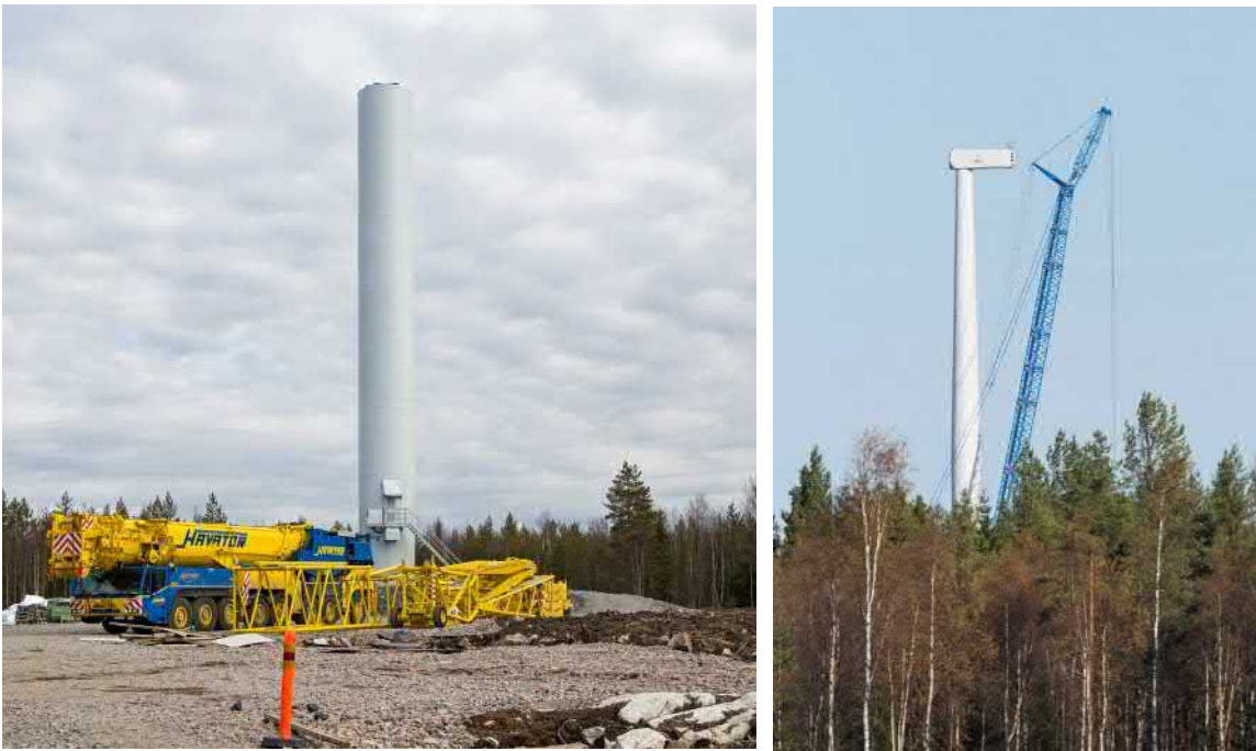
Kuvapari 4.16. Voimaloiden kokoamista (kuvat: Ville Suorsa/FCG).
