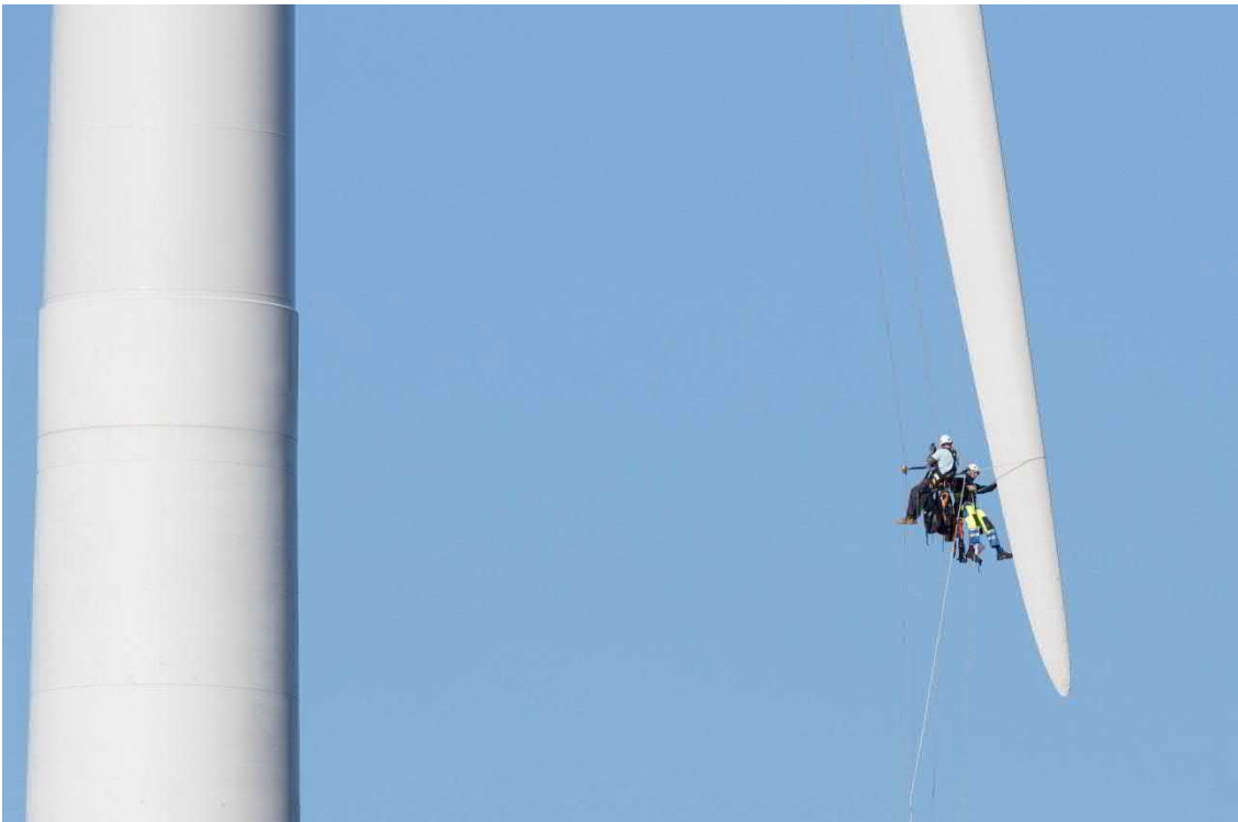
Kuva 4-18. Tuulivoimalan huoltotoimenpiteitä. (Kuva: Ville Suorsa, FCG).
