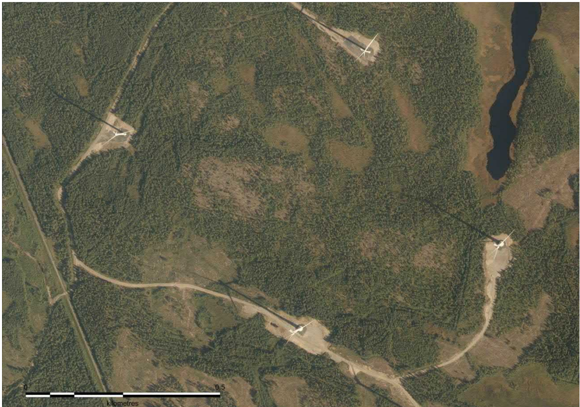
Kuva 4.1. Ilmakuvasa näkyy toiminnassa olevia tuulivoimaloita. Tuulivoimaloita varten on rakennettu huoltotiet ja nostokentät. Tuulivoimaloiden ympäristössä ja välialueilla aikaisempi maankäyttö on säilynyt ennallaan.
