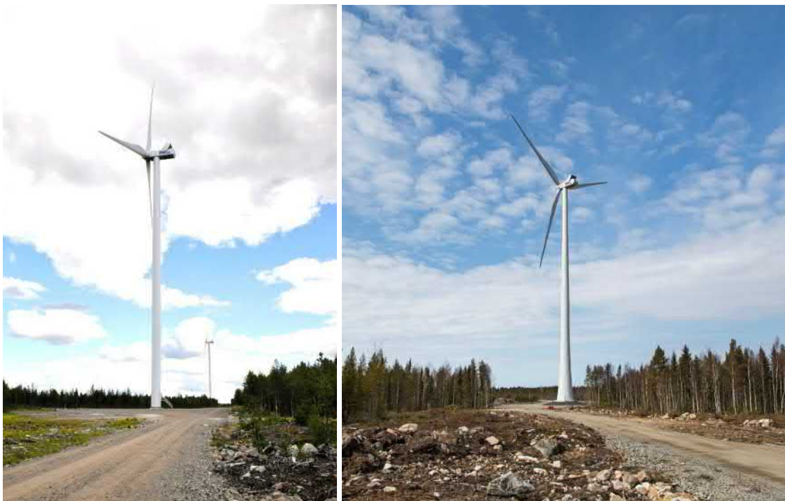
Kuva 4.2. Vasemmalla on esimerkki teräslieriötornista ja oikealla hybriditornista. (Kuvat: Leila Väyrynen ja Ville Suorsa, FCG)
