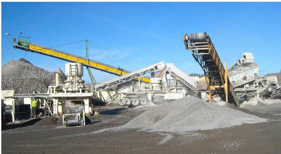
Kuva 3-6. Esimerkki kivenmurskaamosta. Kuva ©: Ympäristöministeriö 2020 / Jari Rintala.
